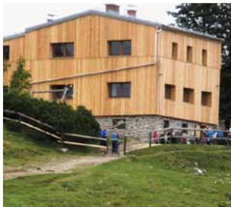
Zunanja fasada je toplotno izolirana in oblečena z macesnovim lesom, ki se odlično vklaplja v okolje, foto Tone Tomše
